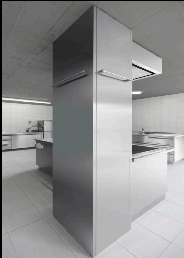
Colonne entièrement revêtue d'acier inox
